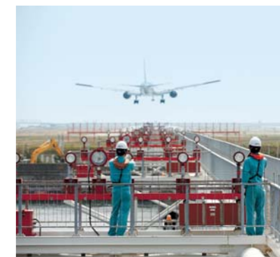
航空機を滑走路に導く進入灯のメンテナンス
