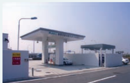
JHFC関西空港水素ステーション
