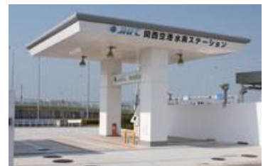
関西空港水素ステーション
